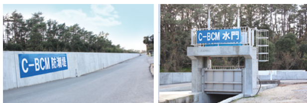
C-BCMに基づき、防波堤、水門の点検・整備も行う
