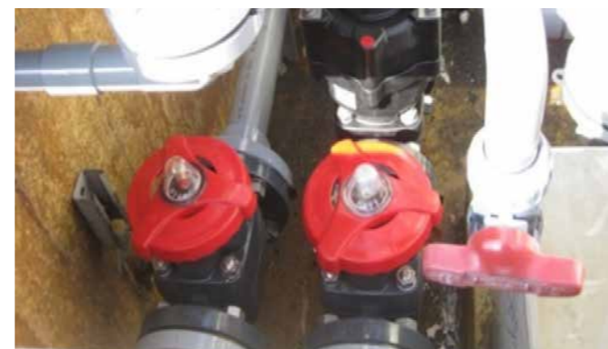
薬品漏洩対策 緊急遮断弁アンカー設置
