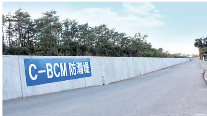
津波対策の防波堤
