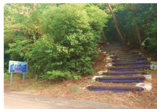
地域住民も利用できる避難路の整備
